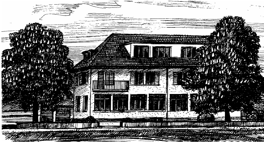
Schulhaus von Werdt nach dem Umbau von 1959
